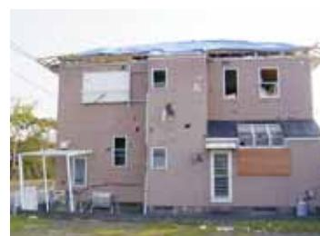
写真3 Windborne missileによる二次被害
