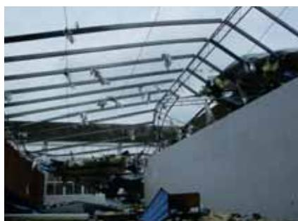
写真1 スチール屋根葺材が全て剥がれている
