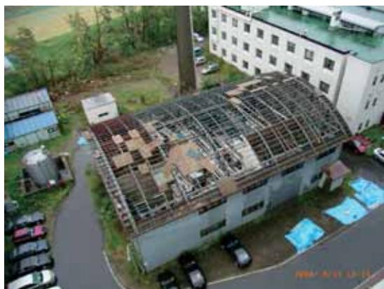
写真9 ボイラ棟の屋根の飛散
