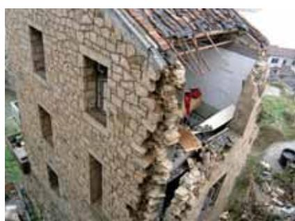
写真3 住家の倒壊（現地では石で住宅を作る習慣がある）
