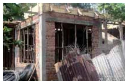
図4 ベトナム・フエ柱梁+空洞レンガ構法
