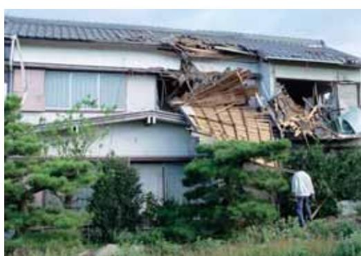
写真13 飛散物による外壁の被害
