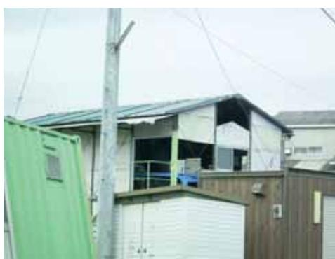
写真11 屋根や壁材の破損と飛散の様子
