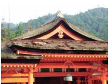
写真6 被害を受けた桧皮葺の屋根
