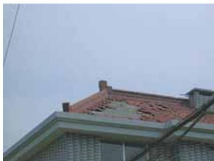
写真2 屋根瓦の被害
