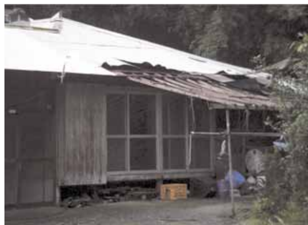
図3 張り出した小屋組みが吹きあげられ飛散
