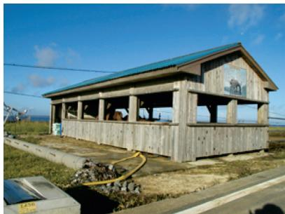
写真5 無被害の畜舎に隣接する電柱は折損している。
