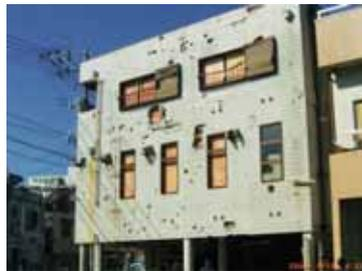
写真3 飛散物による顕著な被害(船倉町)
