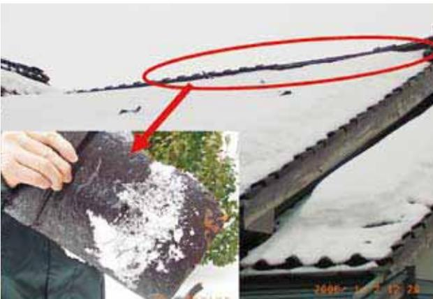
住宅屋根の棟瓦の飛散被害
