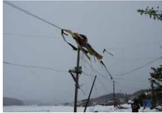
同建物から飛散したと思われる屋根ふき材 ( 峰浜村役場提供 )
