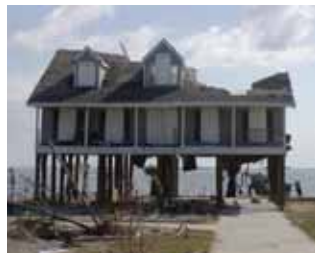
写真 18 海に面した高床式住宅の被害
