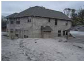
写真 12 決壊堤防背後の民家
