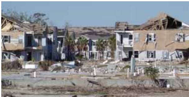
写真 9 高潮と強風による住宅の被害
