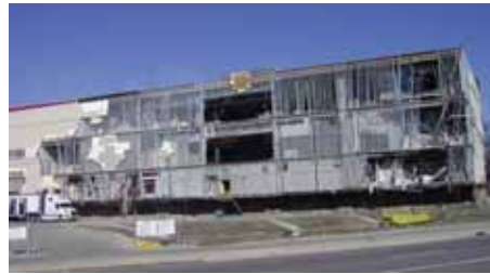
写真 17 カジノ船の陸上への打ち上げ
