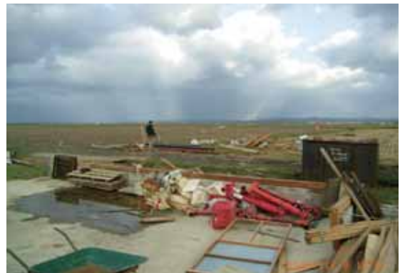
地点1 手前農業倉庫倒壊跡，後方へ飛散物が広がっている
