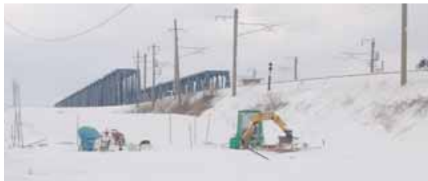
地点3 脱線事故付近の農業倉庫被害跡
