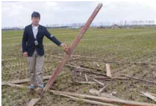
地点3と4の間に飛散した建物の骨組が突き刺さっている。人力では抜けなかった。
