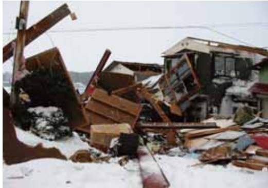
大沢地区の木造 2 階建事務所の倒壊 ( 峰浜村役場提供 )
