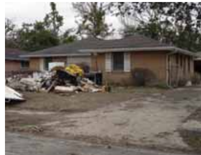
写真 10 屋根ふき材の被害
